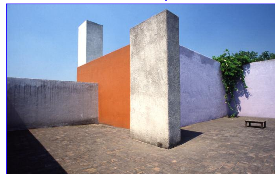
Patio-terrasse de la Maison-atelier Barragan.
